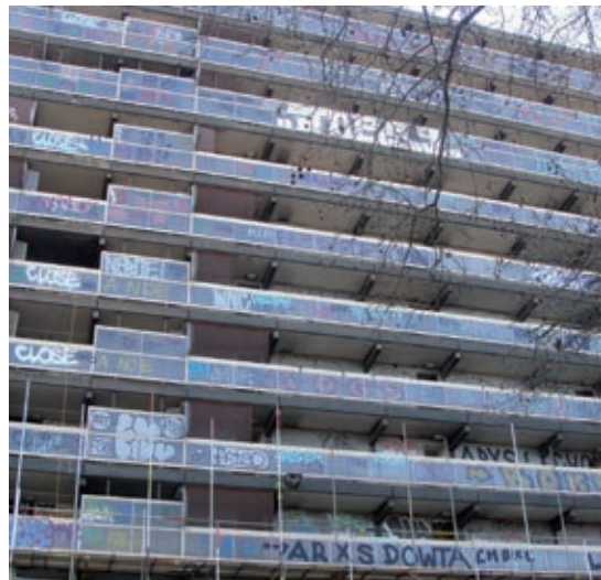
Foto 2: Heygate Estate completament buit a l'espera de la seva demolició, 2014. (Foto: Lenimar A rends).
