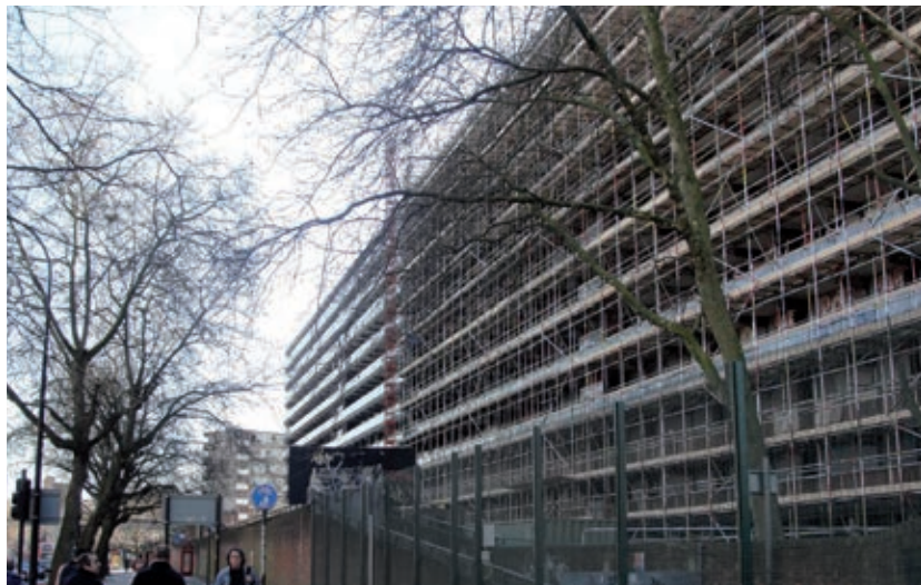
Foto 1: Heygate Estate completament buit a l'espera de la seva demolició, 2014 (Foto: Lenimar Arends).
