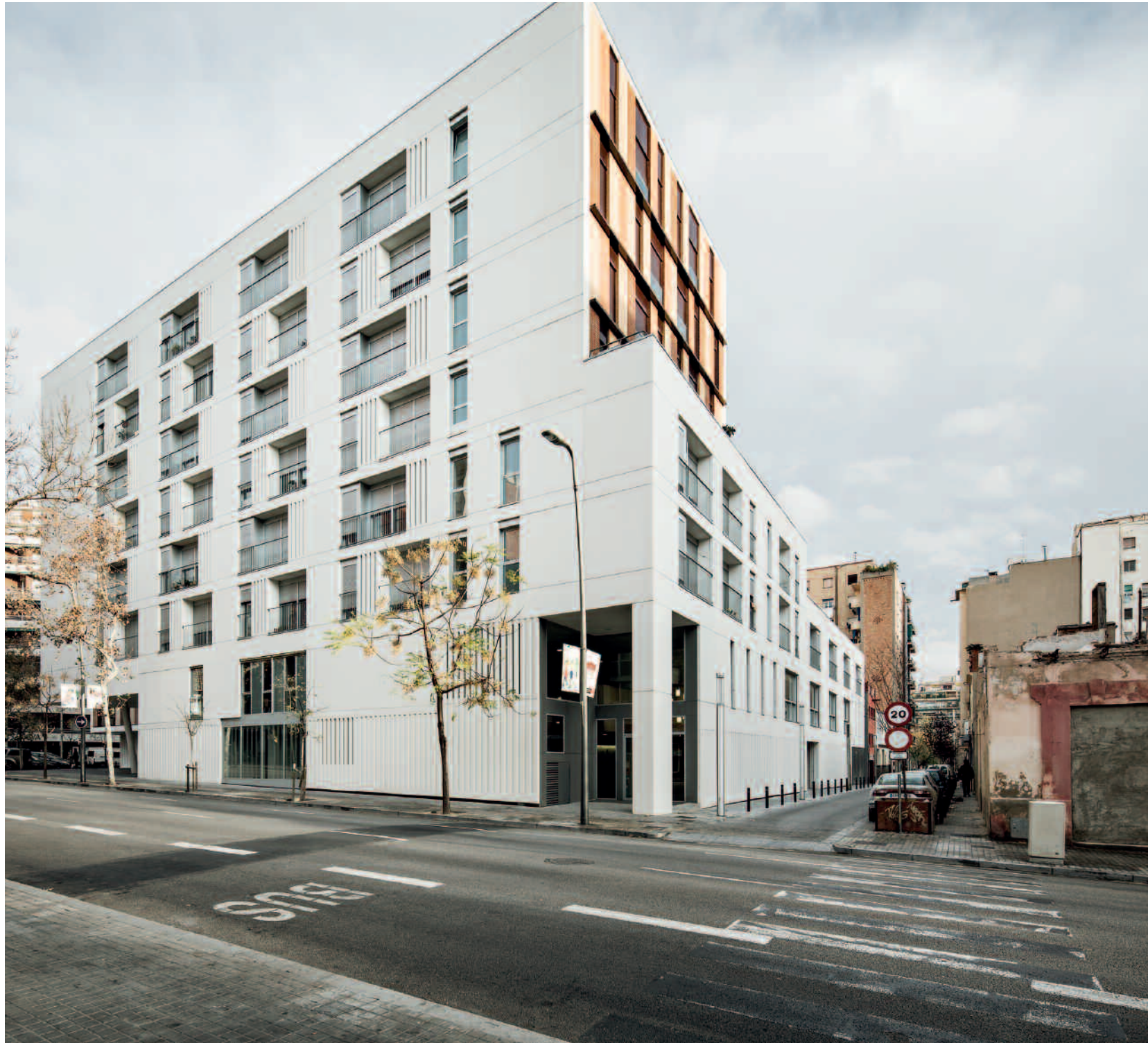
Navas de Tolosa, 310. Arquitectes: Txema Onzain, ONL Arquitectura
