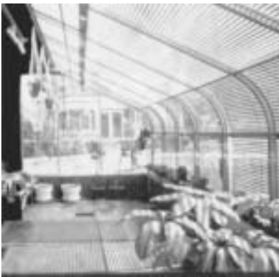
Fig. 6. Galeria en un habitatge.
