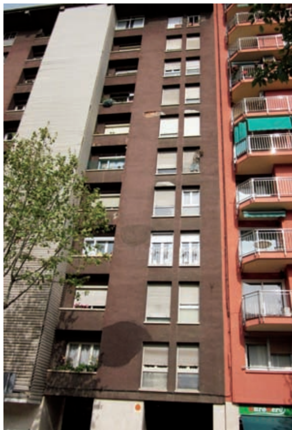
Imatges de l'abans i el després de les obres de rehabilitació de la façana de l'edifici de Gran Via, 1135
