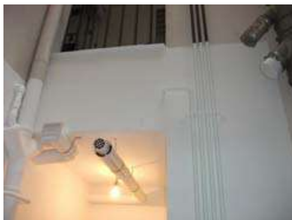
Imatges de la reforma interior d'un habitatge a Arc de Sant Pau, 23. Detall de la cuina i el pati interior.
