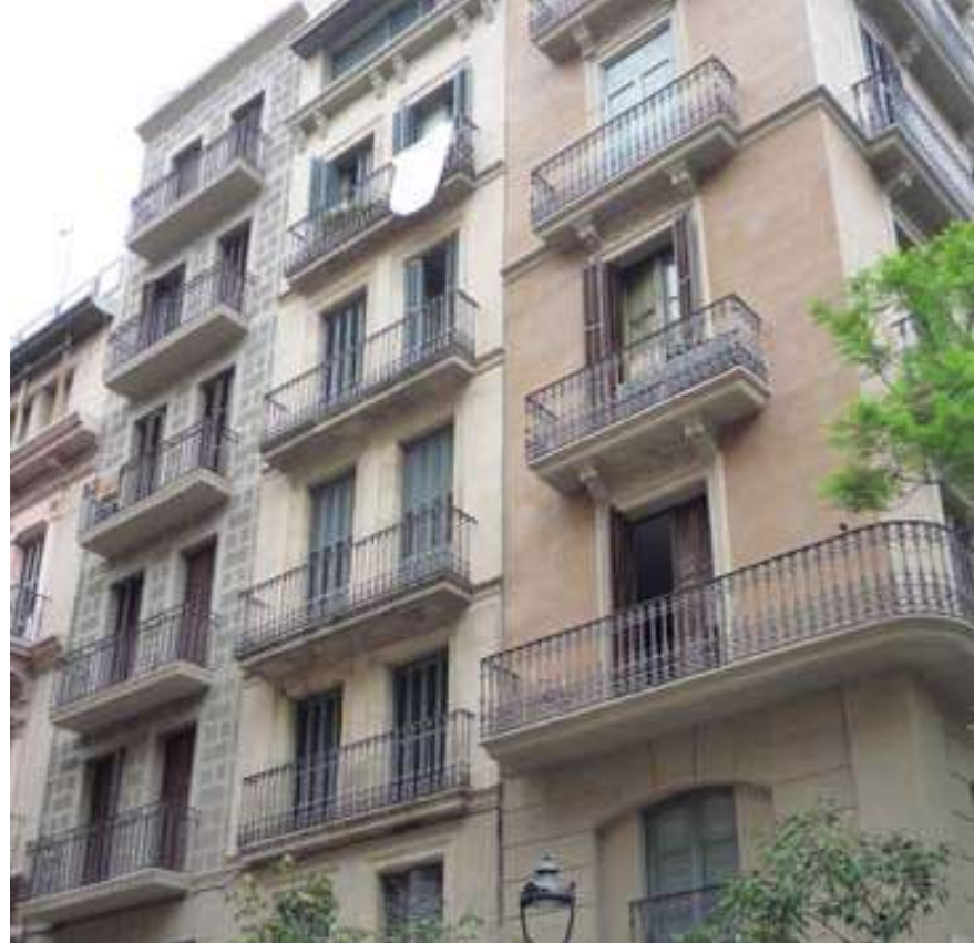
Imatges d'abans i després de la rehabilitació d'una façana al carrer Fusina.
