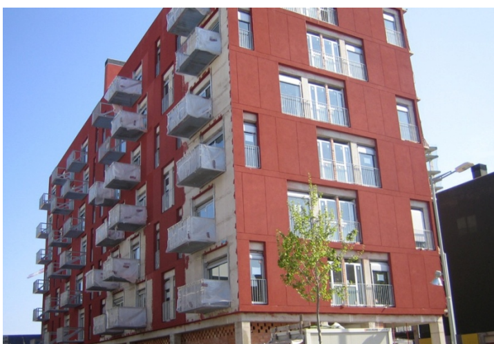
c/ de Llull, 418 (edifici nord); c/ de Pierre Vilar, 5 (edifici sud); c/ de Llull, 420 (edifici est) 72 habitatges de lloguer en règim general a 25 anys. Promotor: PMHB
