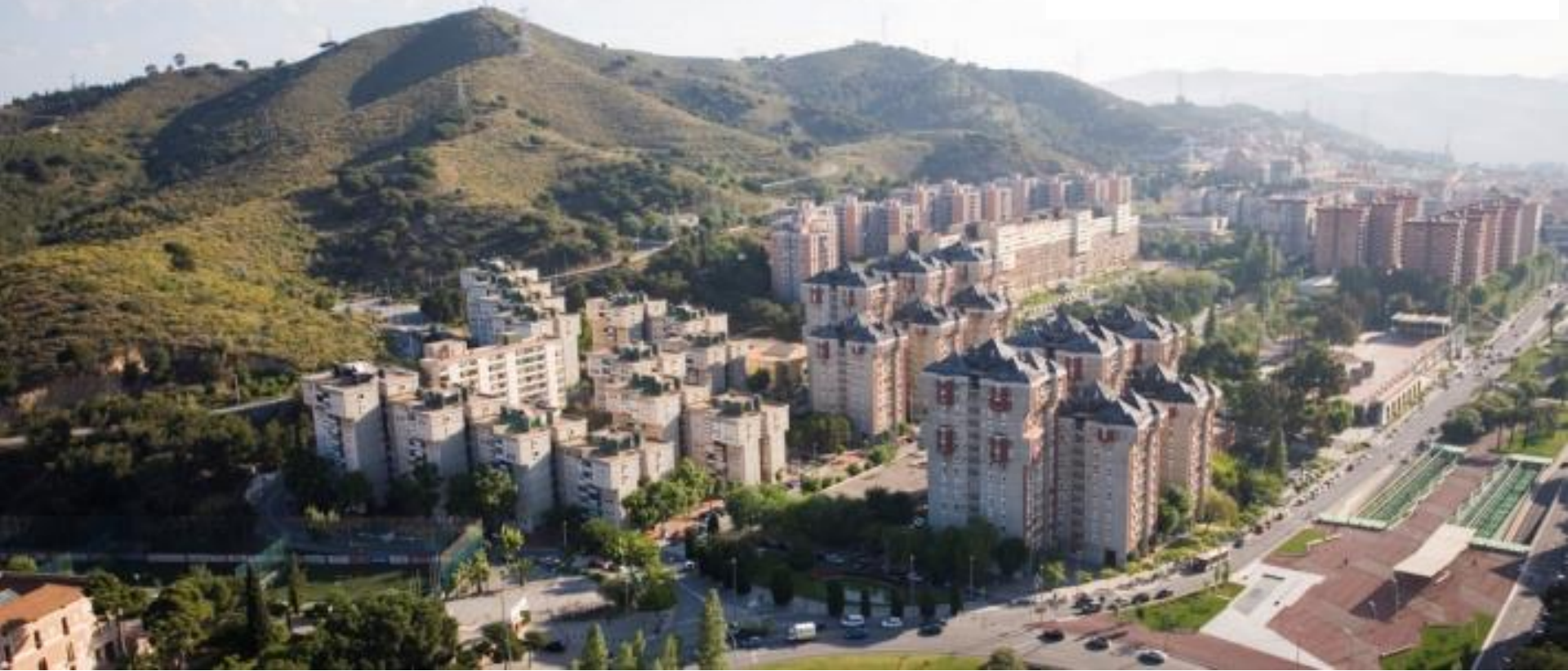
Edifici A16, calle Miguel Hernández 14, Canyelles
